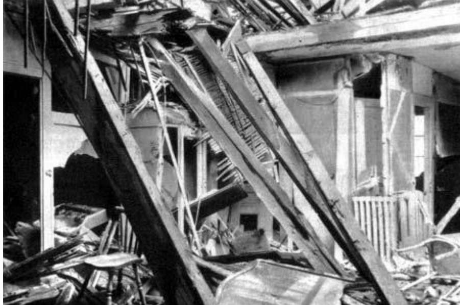
Les dégâts dans un chambre de l'hôtel Beau-Séjour
