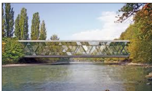
Vu de l'aval
